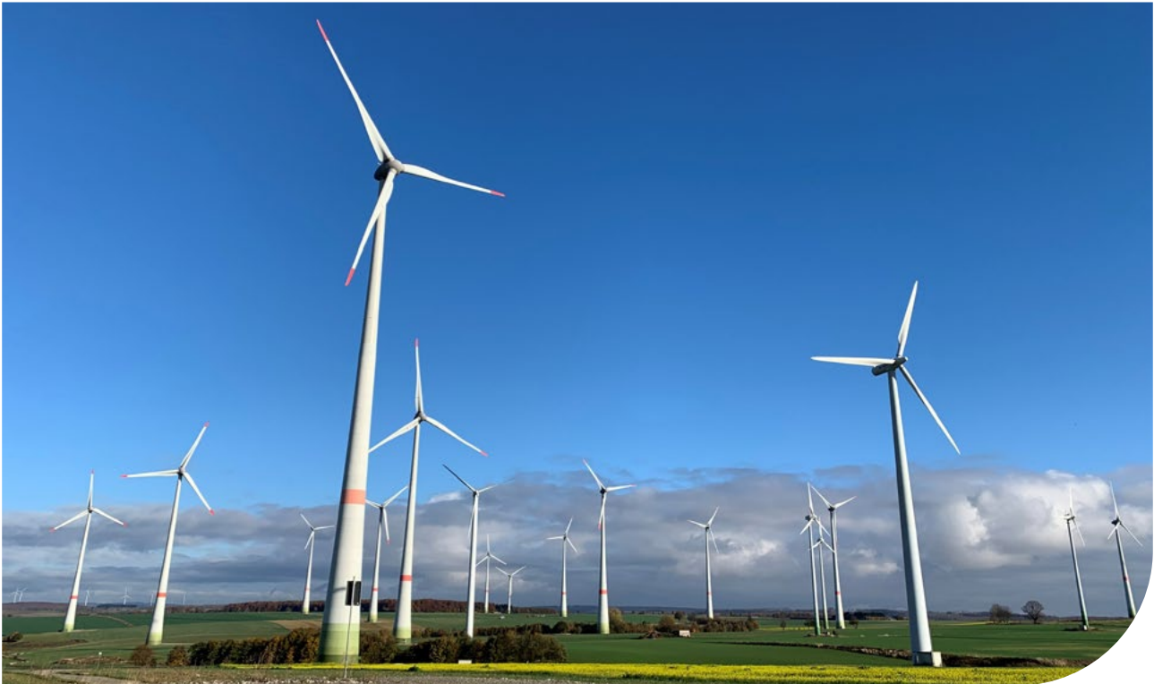
Verachtfachung der installierten Leistung durch Repowering.
